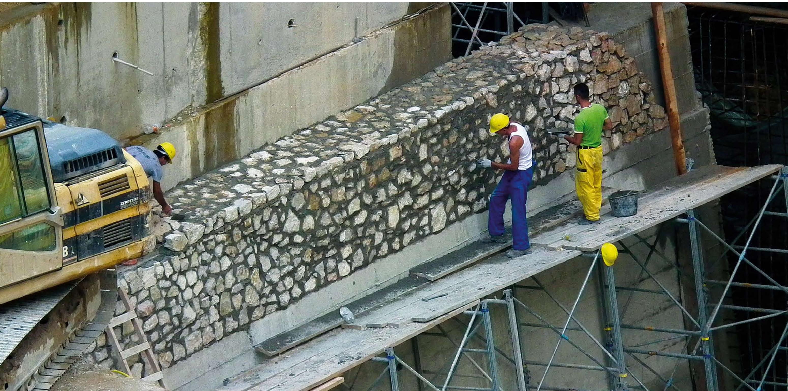
Pripremni radovi za betoniranje armiranobetonske ploče bućnice (desno)
