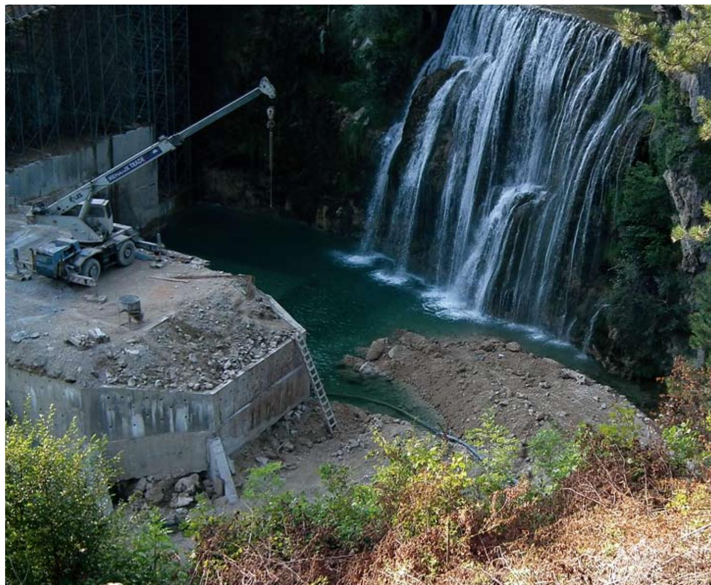
Pristupni put i zagat za regulaciju vodotoka u bućnici (desno)
