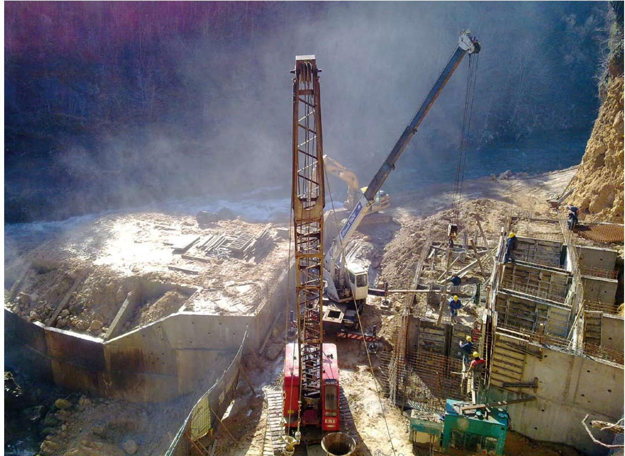
Izrada armiranobetonskih perforiranih zidova kazeta desno)
