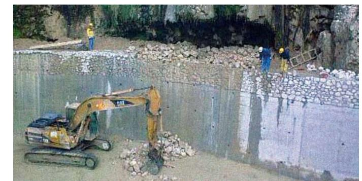
Demontaža bočne oplate armiranobetonske ploče bućnice (dolje lijevo)
