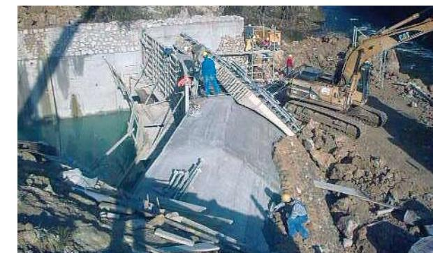
Montaža oplate i pripreme za betoniranje preljevnog praga (lijevo)
