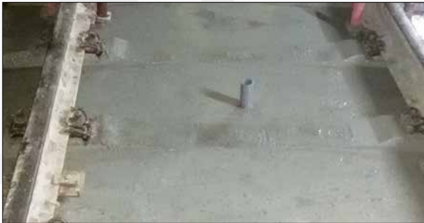
Slika 9. Ugrađen i površinski obrađen beton
