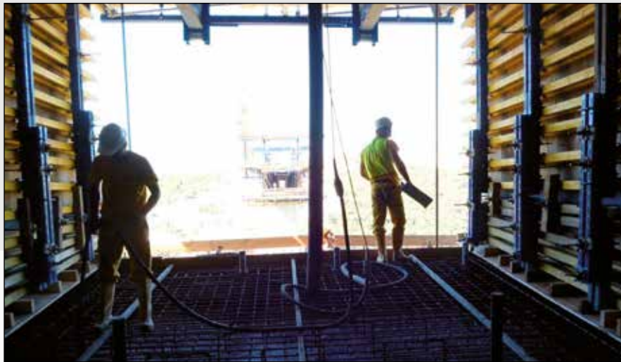
Slika 12. Betoniranje donje ploče segmenta u oplati za slobodno konzolnu gradnju
