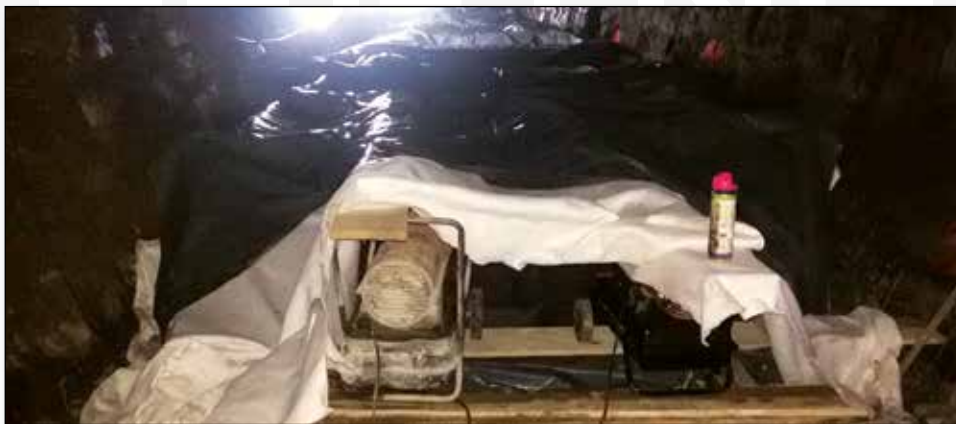
Slika 11. Njega mladog betona grijanjem pomoću topova
