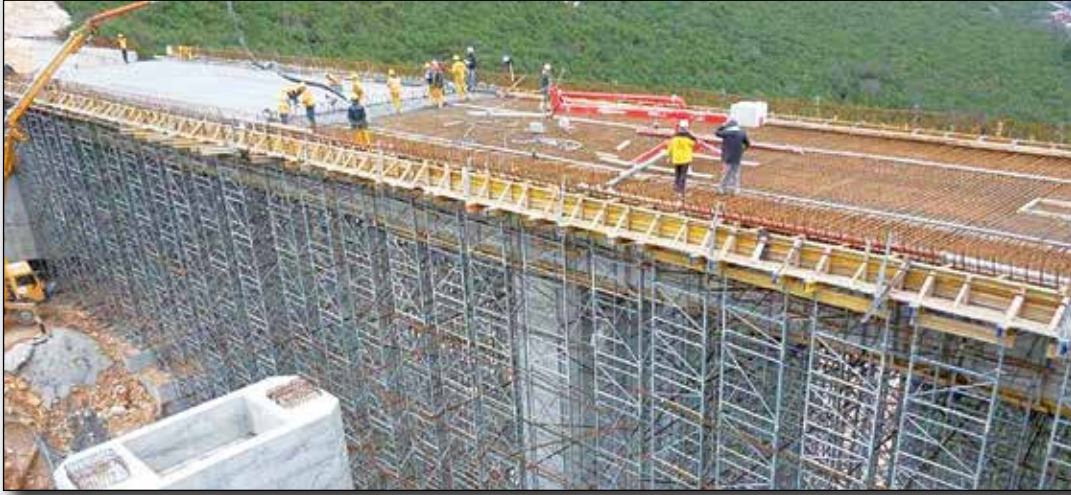
Slika 15. Betoniranje rasponske konstrukcije S4D mosta Studenčica s kombiniranim transportom betona autopumpom i stacionarnom pumpom s razastiračem za beton
