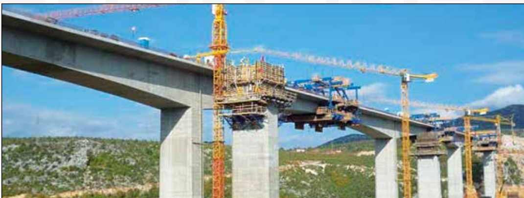
Slika 2. Most Studenčica, faza izgradnje
