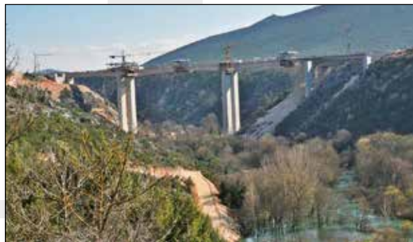
Izgradnja rasponske konstrukcije mosta Trebižat Construction of span structure of Trebižat Bridge
