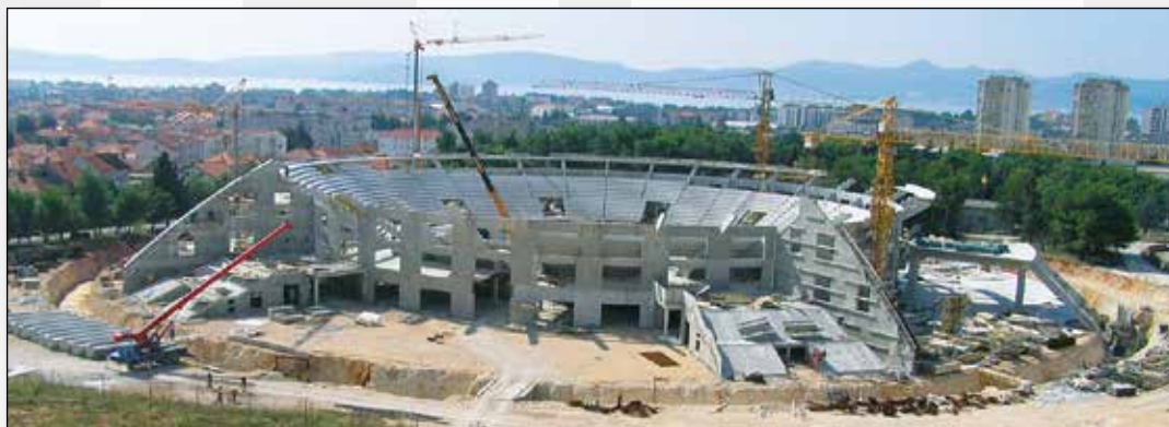
Slika 7. Pogled na gradilište prije početka radova na kupoli
