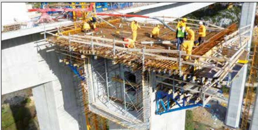
Slika 6. Faza izgradnje, izrada baznog dijela rasponske konstrukcije
