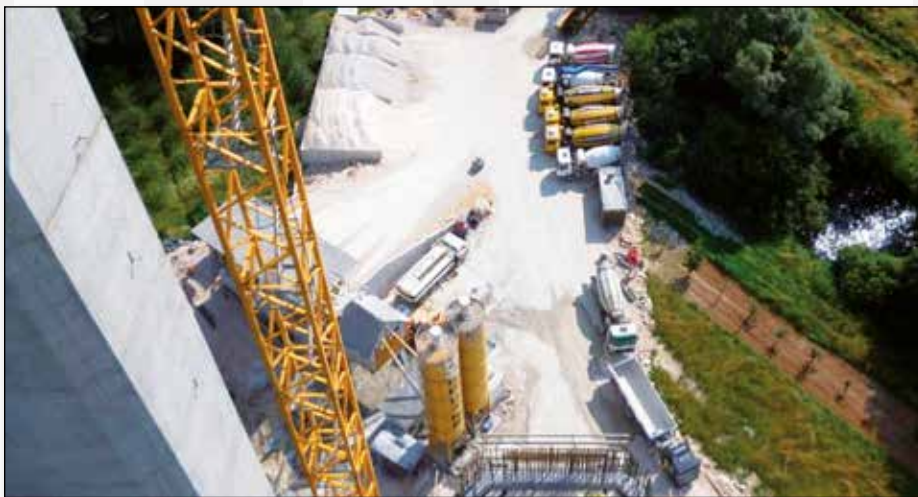
Slika 5. Tvornica betona na gradilištu mosta Studenčica
