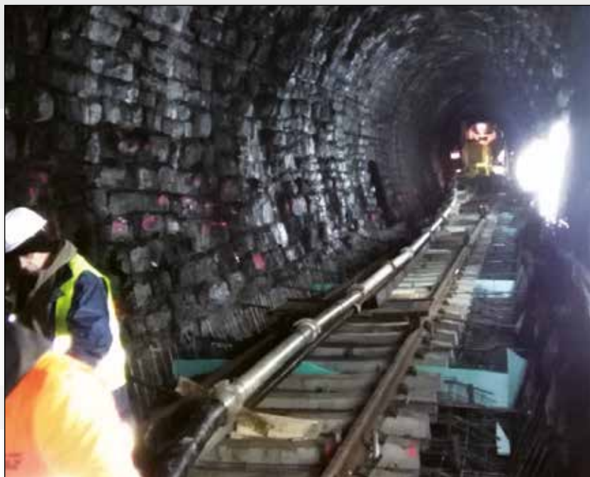
Slika 7. Beton transportiran do mjesta ugradnje
