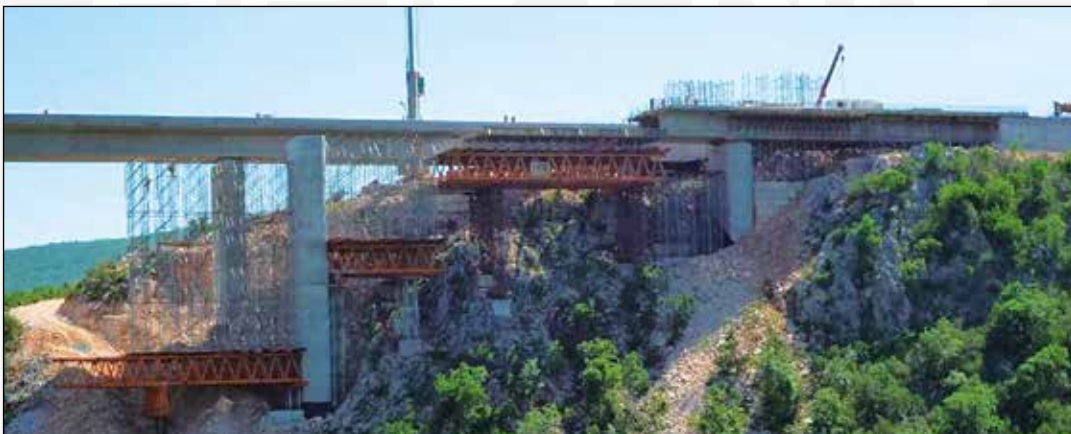
Slika 4. Faza izgradnje, izgradnja dijela rasponske konstrukcije mosta Trebižat na skeli
