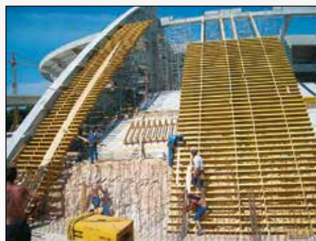
Slika 8. Postavljanje oplata i skele
