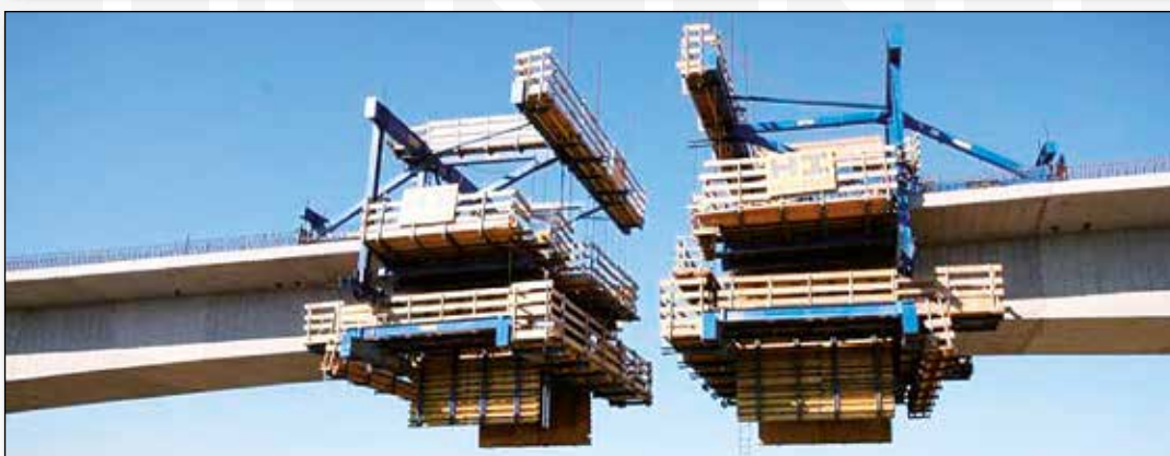
Slika 16., 17., 18. Faza izgradnje / Figure 16., 17., 18. Construction stage
