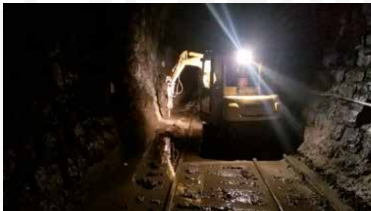
Slika 5. Pripremljeni iskopi podloge, nova drenažna središnja linija i novi pragovi i tračnice za postavljanje
