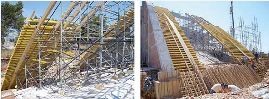
Slika 9. Postavljanje oplata i skele
