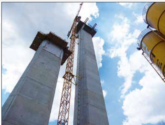
Slika 9. Cjevovod za beton S3 desno Most Studenčica
