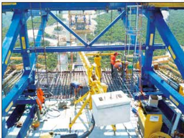
Slika 13. i 14. Ugradnja betona rasponske konstrukcije građene slobodno konzolnom gradnjom i na skeli
