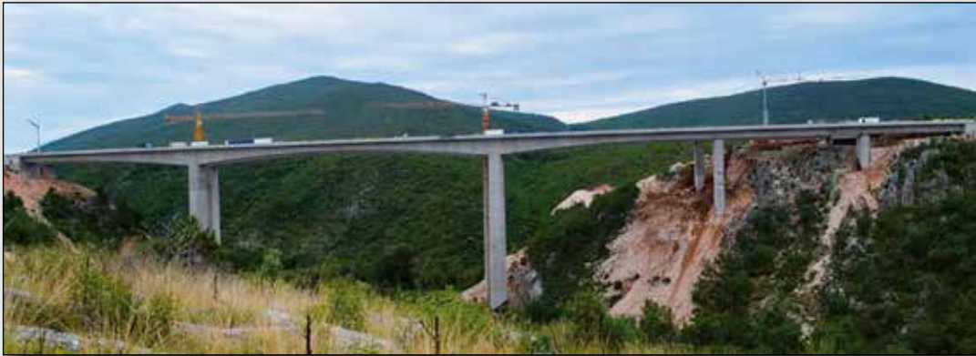
Slika 3. Most Trebižat, armiranobetonska građevina, autocesta, koridor 5C
