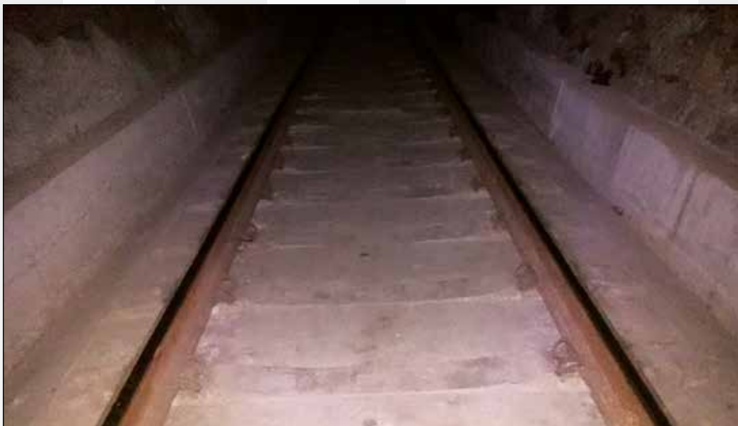
Slika 12. AB ploča u tunelu Ivan
