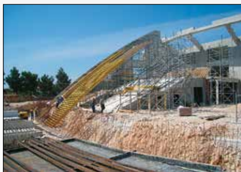
Slika 8. Postavljanje oplata i skele
