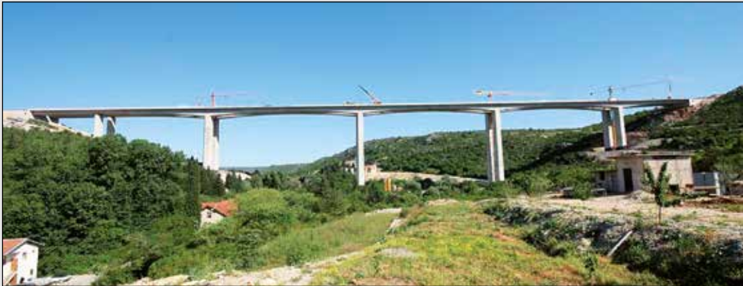
Slika 1. Most Studenčica, armiranobetonska građevina, autocesta, koridor 5c
