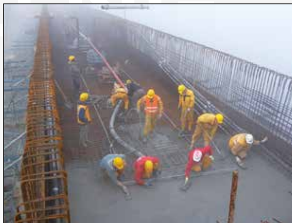
Slika 13. i 14. Ugradnja betona rasponske konstrukcije građene slobodno konzolnom gradnjom i na skeli
