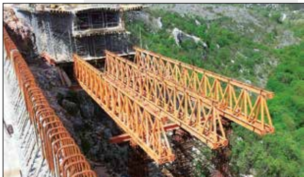
Izgradnja rasponske konstrukcije mosta Trebižat oslonjene o tlo Construction of Trebižat Bridge span structure resting on the ground
