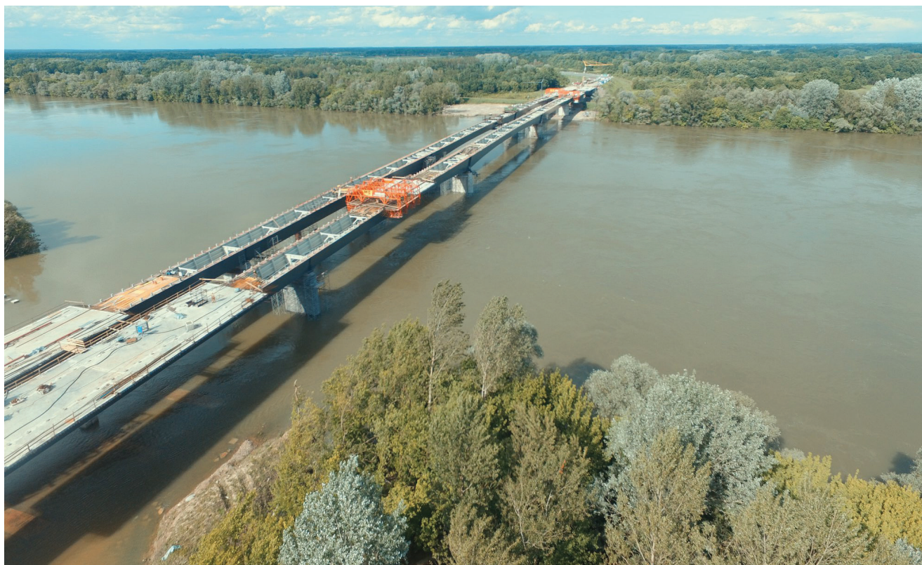
Pogled na gradilište mosta iz zraka
