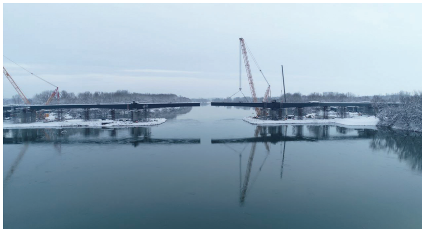
Pogled na gradilište, snimljeno u veljači 2019.
