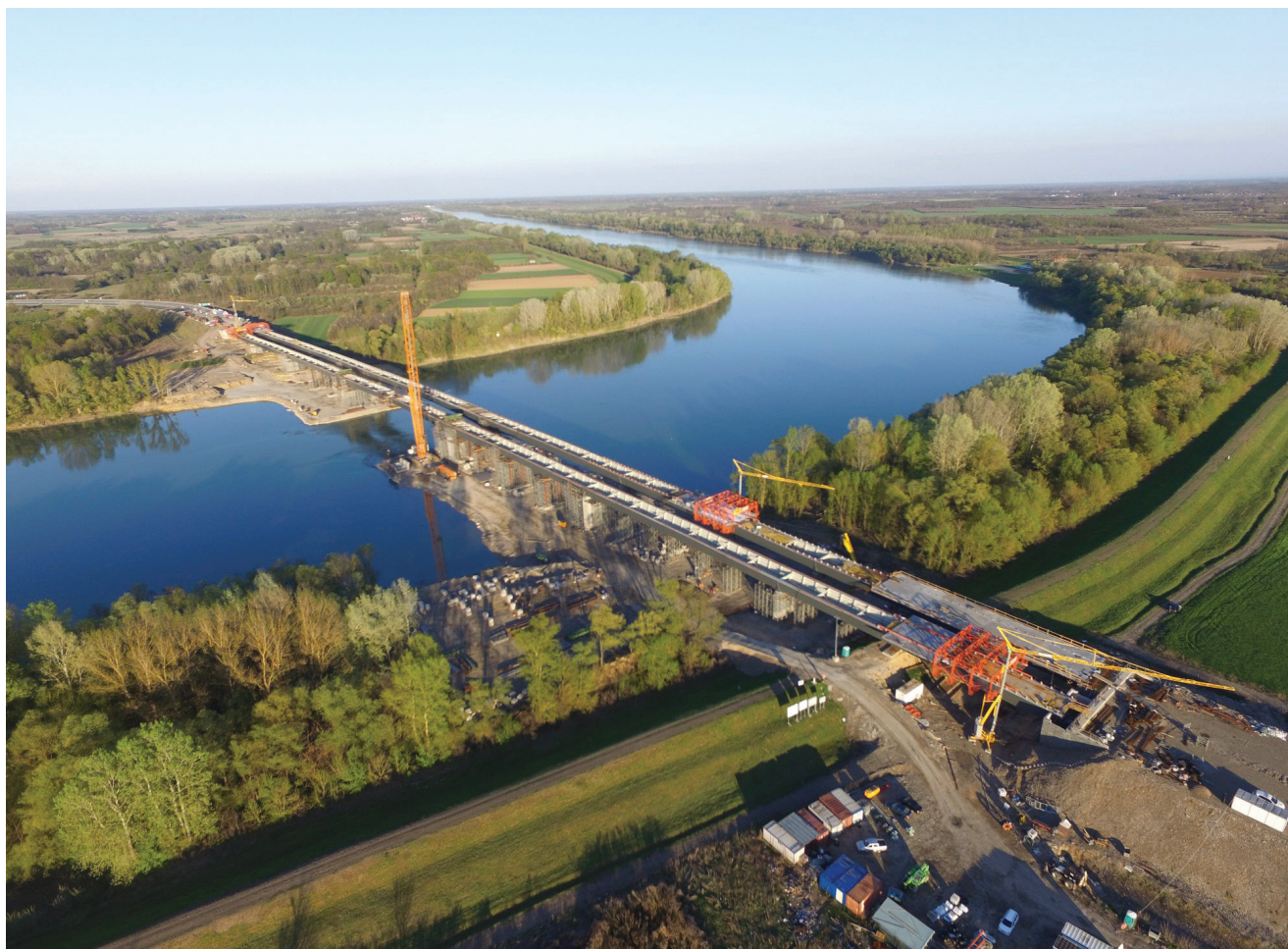
Pogled iz zraka na gradilište mosta Svilaj
