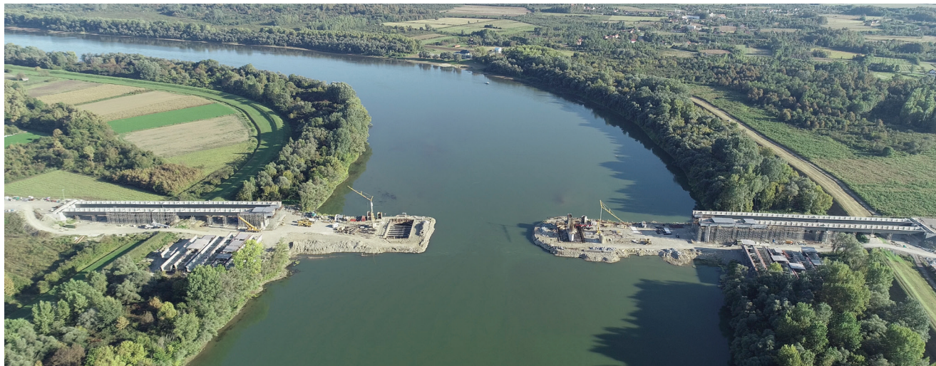
Pogled na gradilište
