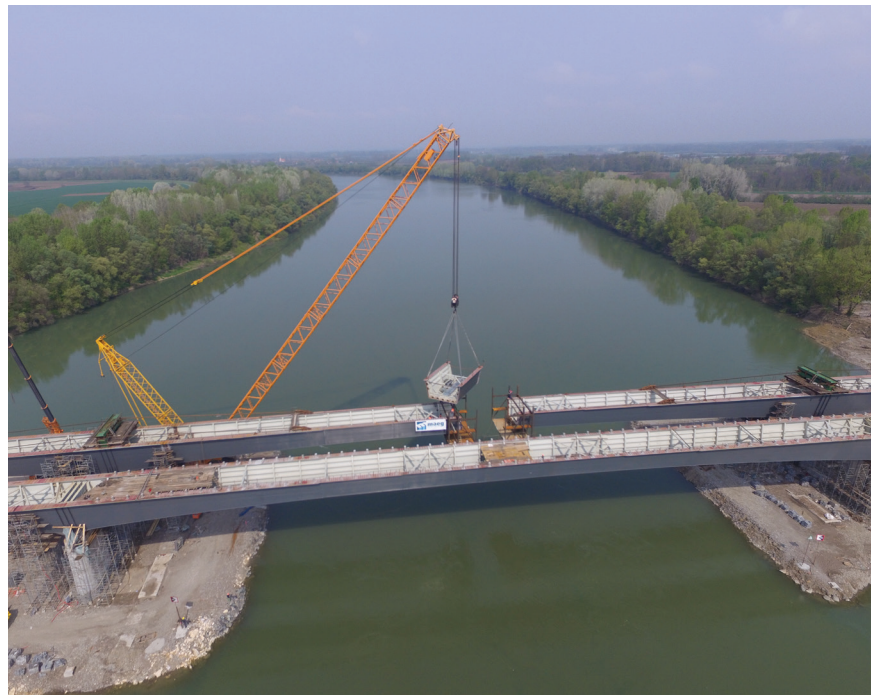
Ugradnja posljednjeg makroelementa čelične konstrukcije mosta
