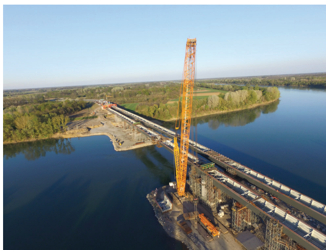
Detalji s gradilišta
